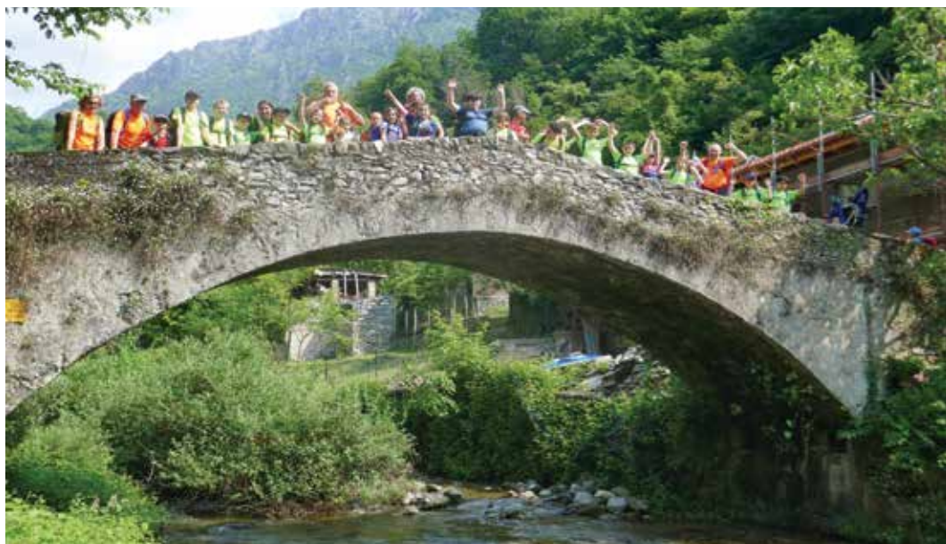
Caratteristico ponte in Val Sanagra
